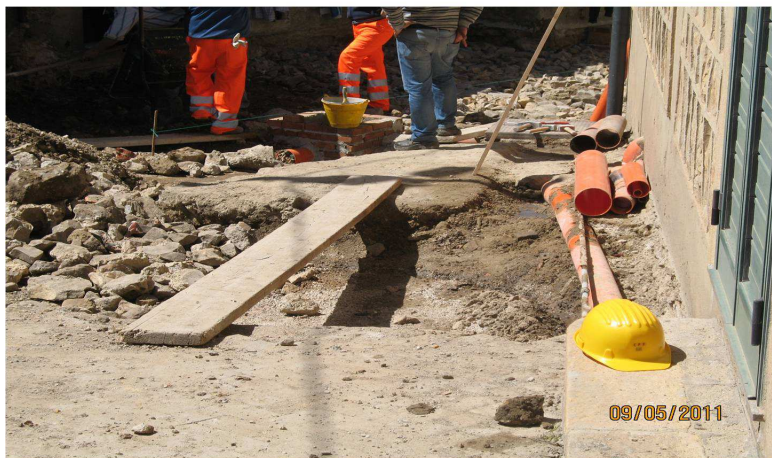
CANTIERE DI LAVORO VIA S. BARBARA
